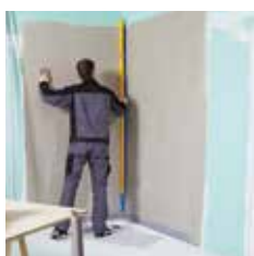
1. Wandflächen nach Vorschrift vorbereiten
