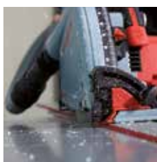
3. Platten zuschneiden und entgraten
