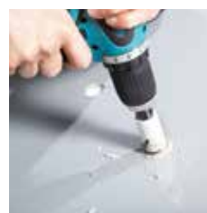
4. Durchgänge bohren und entgraten
